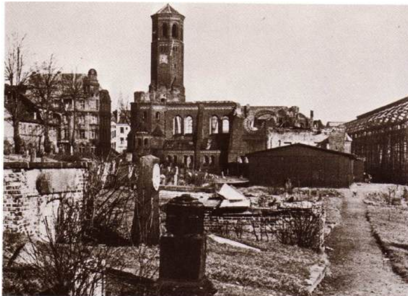
St. Jürgen Kirche mit Notdach und dem zerstörten Friedhof
